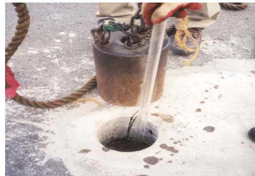
(d) 외부 아크릴 케이싱 설치
