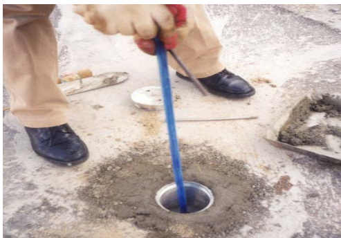
(e) 투명 아크릴관 설치
